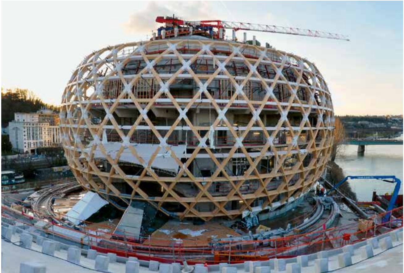
Die 3000 Holz-Einzelteile wurden aus Deutschland geliefert und vor Ort zusammengesetzt.
