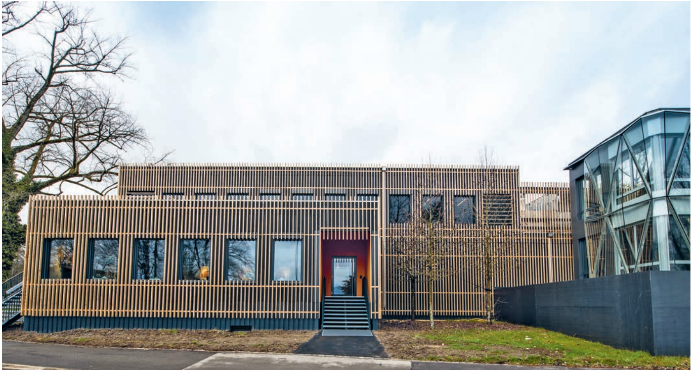
In nur vier Monaten wurde das 52 Meter lange und 43 Meter breite Restaurant-Provisorium gebaut.
