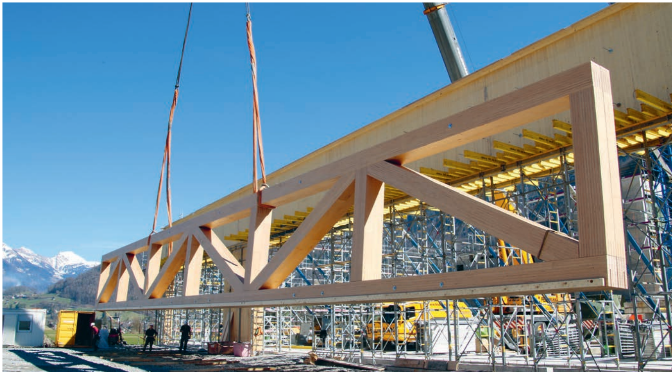
Die je zwölf Tonnen schweren und 32 Meter langen Fachwerkträger rollten per Spezialtransport vom Appenzellerland ins Glarnerland. Die Aufriichte erfolgte umgehend und bei bestem Wetter.
