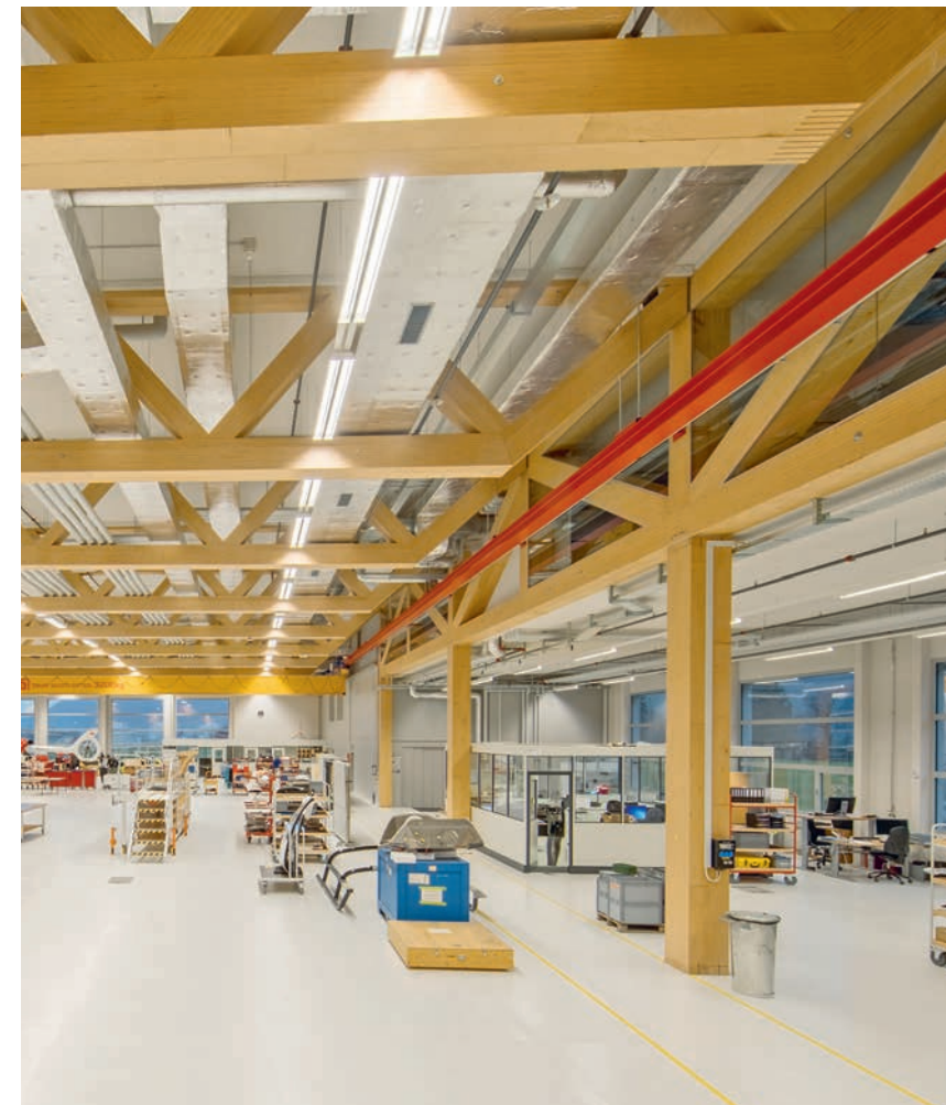
Zwölf doppelte Fachwerkträger aus BauBuche überspannen eine Hallenbreite von 32 Metern. Die Verjüngung zu den Auflagern ermöglichte die Montage von Kranbahn-Schienen.
