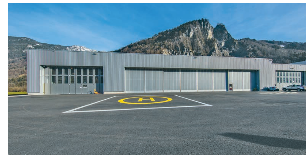
Ein Holz-Beton-Hybridträger überspannt die zwölf beziehungsweise 37 Meter breiten Toröffnungen. Die neue Montagehalle hüllt sich an der Frontseite in ein glänzendes Blechkleid.
