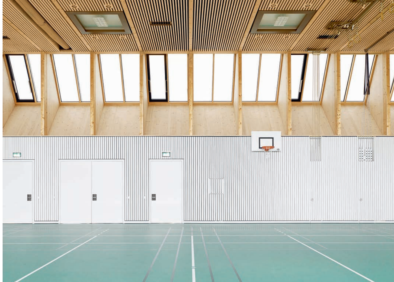
Die zentrale Halle ist für den Schulsport, aber auch für andere Anlässe der Gemeinde geeignet. Zwei längsseitige Fensterbänder im Dach sorgen für viel Tageslicht.
