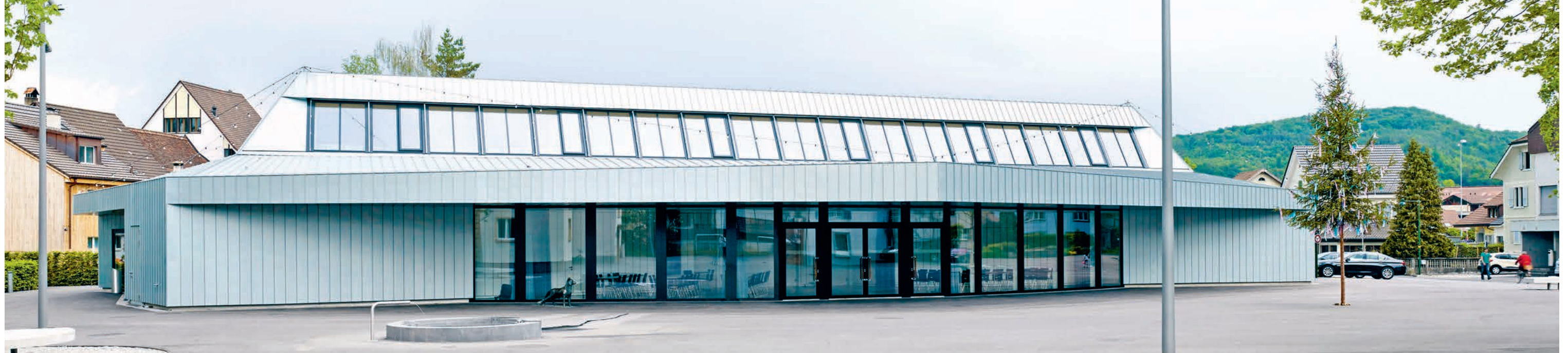
Unter der grauen Zinkfassade der Mehrzweckhalle in Bubendorf (BL) verbirgt sich ein anspruchsvoller Holzbau.
