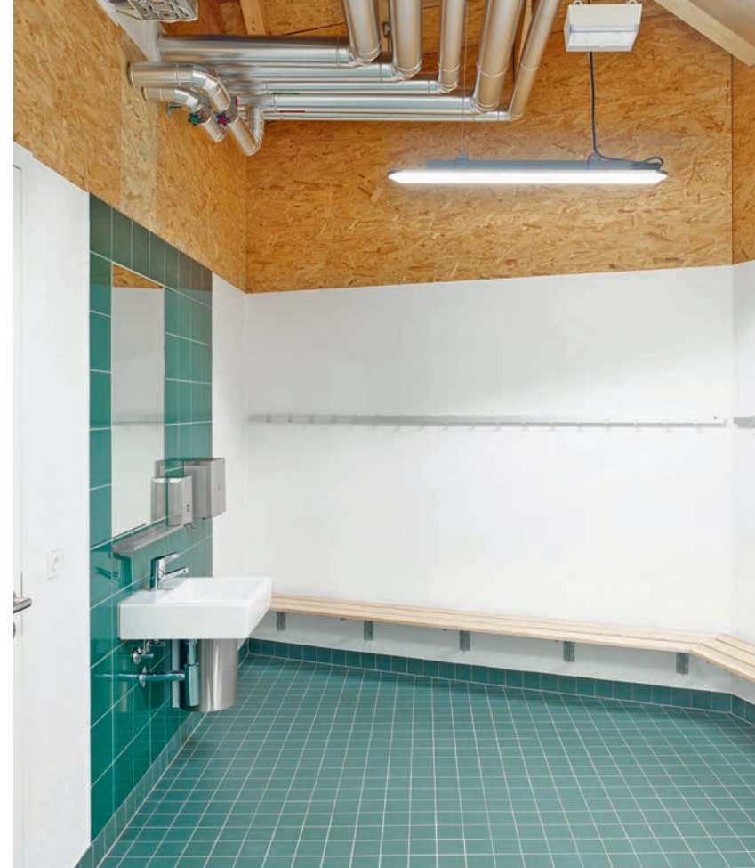
In den Nebenräumen reicht die Wandverkleidung nur bis auf 2,30 Meter Höhe. Darüber ist der hölzerne Rohbau sichtbar.
