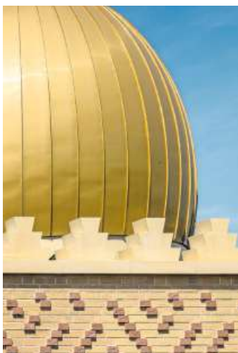
Die vergoldete Kuppel des Doms, der mit einem Kran auf die Decke der Moschee gehoben wurde.
