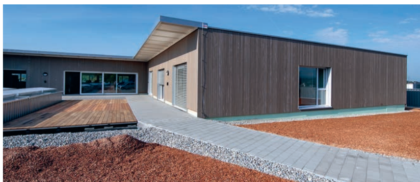
Nur ein kleiner Teil des Dachs ist mit dem 225 Quadratmeter grossen Showroom belegt. Der grösste Teil steht den Mitarbeitenden als Parkfläche zur Verfügung.
