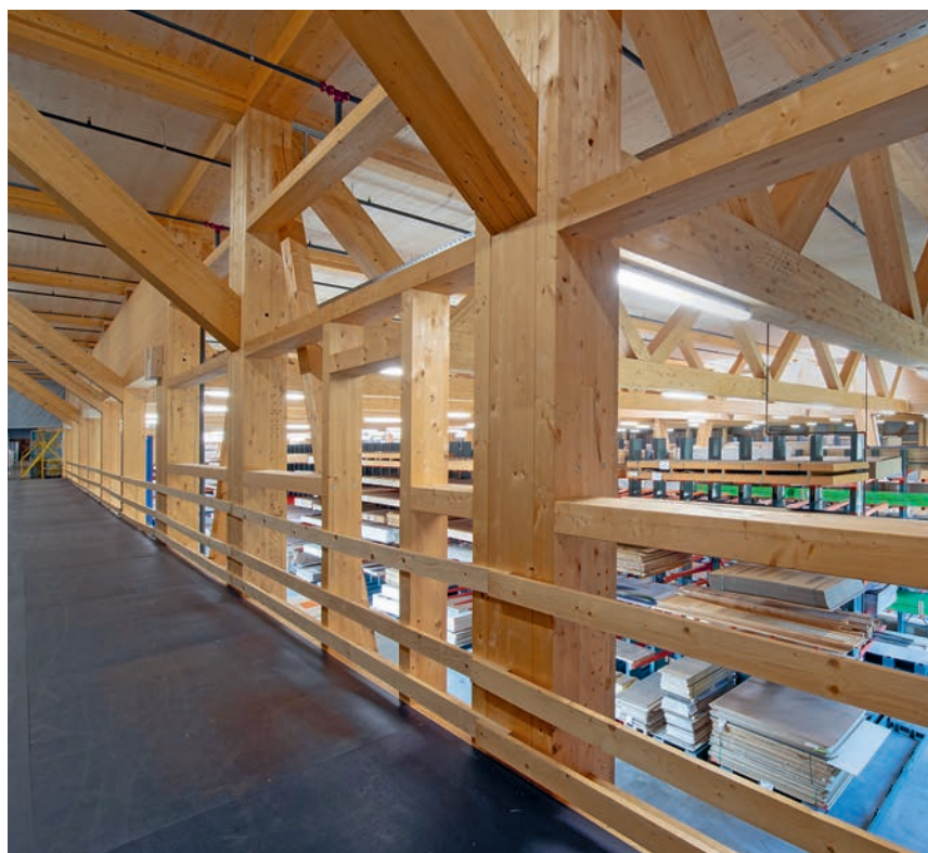
Blick von der Galerie: Die Fachwerkbinder haben eine Spannweite von 25 Metern.
