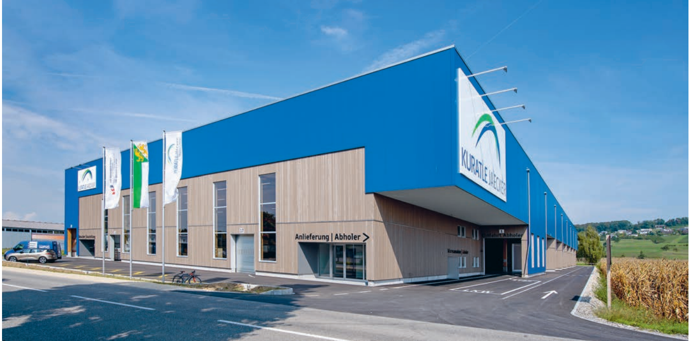
60 Meter breit, 145 Meter lang: Der neue Verkaufs- und Logistikstandort der Kuratle & Jaecker AG im Industriegebiet Märstetten beeindruckt mit Grösse in Holz.
