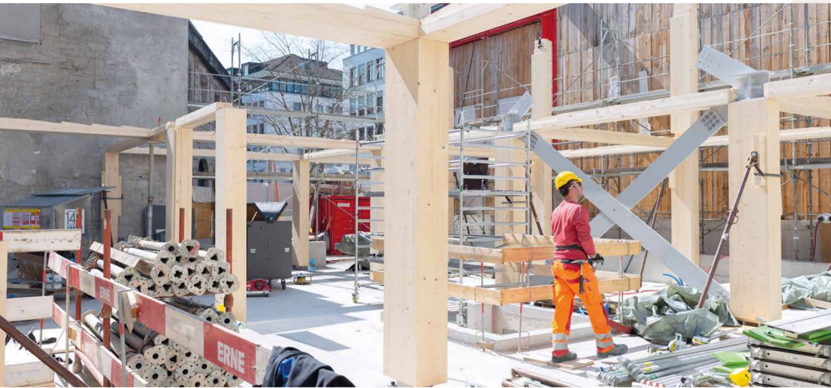
Massives Holz-Skelett mit vorfabrizierten Betondecken (Foto © jessenvollenweider)
