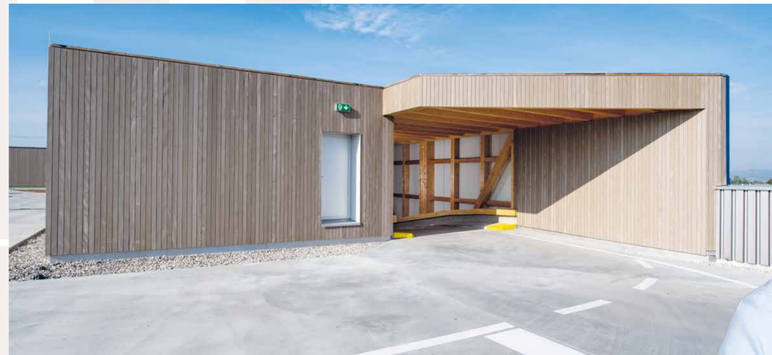
Zufahrt aufs Dach
