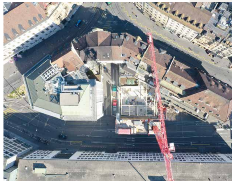
Die Baustelle auf engstem Raum (Foto © jessenvollenweider)
