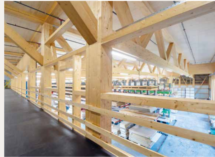
Blick in die Halle
