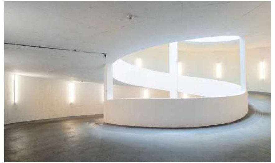
Alle vier Stockwerke sind mit Fahrzeugen über zwei Spindelrampen erreichbar.
